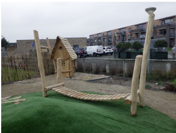
Obstakelvrije Zone ( 1 : 30 ) Obstakelvrije zone dient vrij te zijn van obstakels! Het materiaal van de ondergrond dient geschikt te zijn voor de valhoogte van het toestel!"
